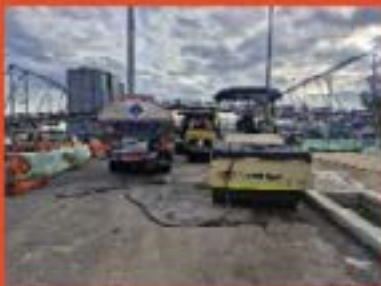
Colocación de mezcla asfáltica
