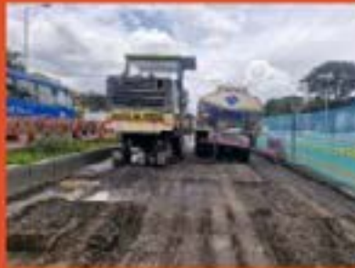
Humectación de vías
